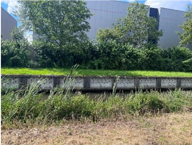
De betonnen oeverwaluwand in Bunschoten.
