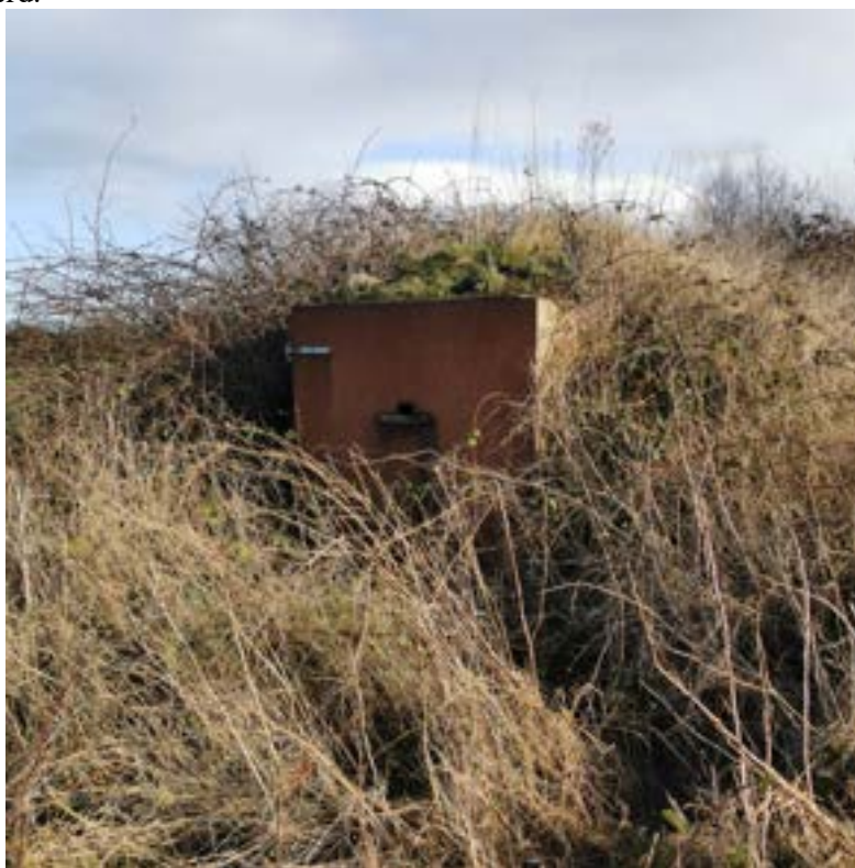
Vleermuisbunker in het nieuwe bos
