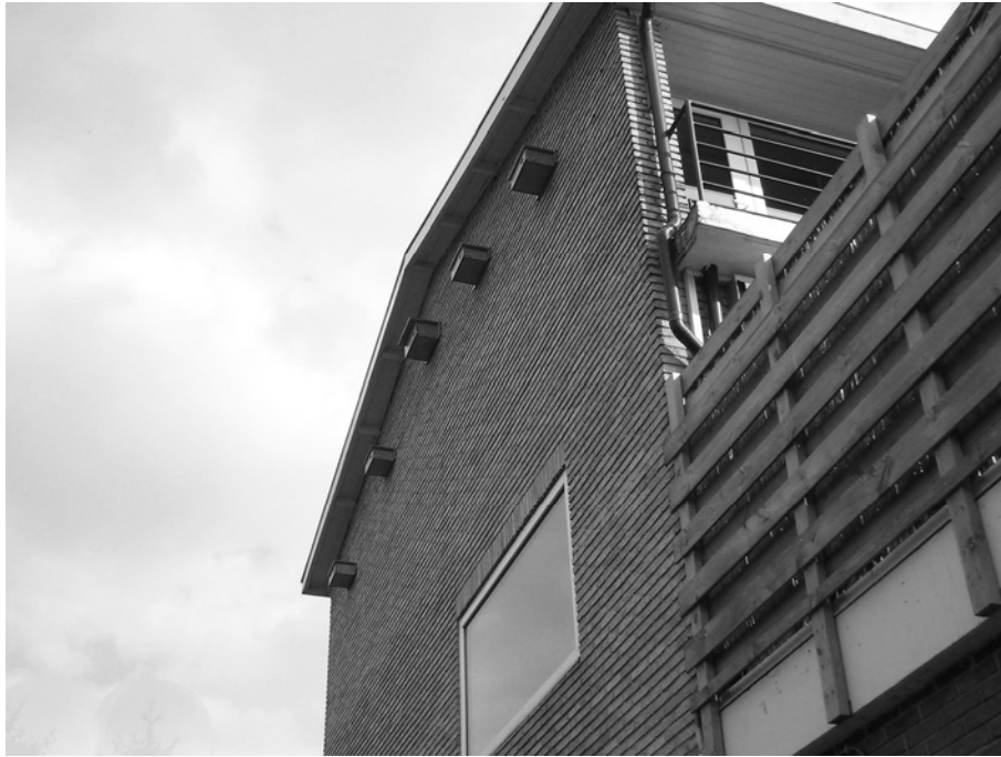
Kasten voor gierzwaluwen aan flat Novaplein
