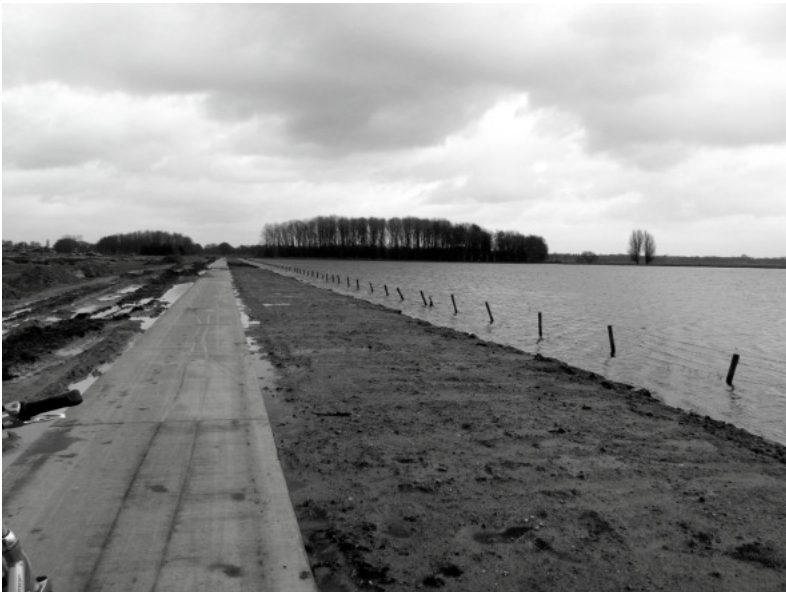
Nieuw fietspad Verlengde Boterdijk
