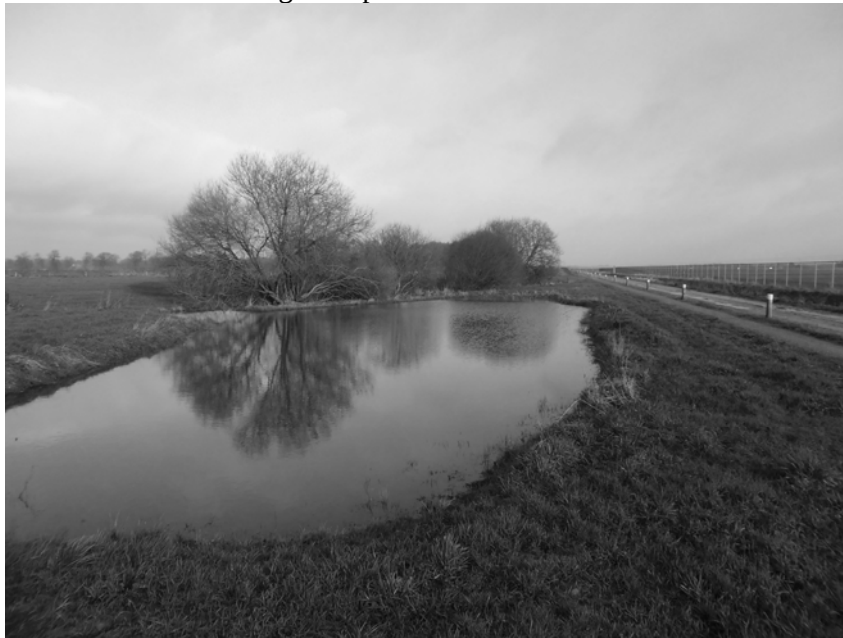
Poel aan de Noordwestzijde van de baanverlenging foto's Leo Stockmann
