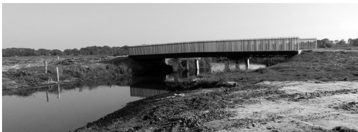
Nieuwe brug over het Eelder Diep (ongeveer 200 m ten westen van het Bakkersbos)
