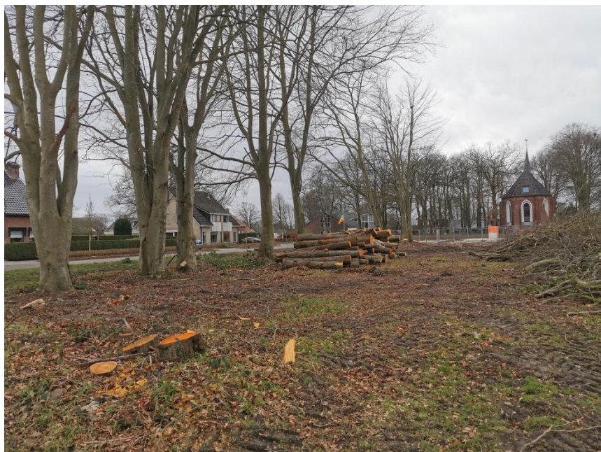
Kapwerkzaamheden oud groen, februari 2023
