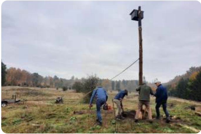
Plaatsing van een nestkast voor torenvalken op de Kleine Heide Foto: Hans Westendorp
