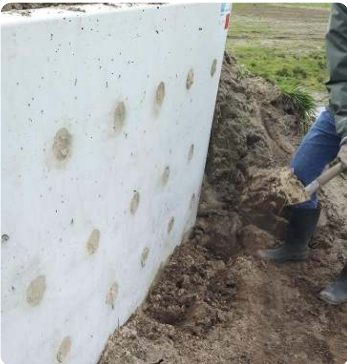
De gaten zijn opgevuld, maar de grond vóór de wand moet nog afgegraven worden Foto: Hans Westendorp
