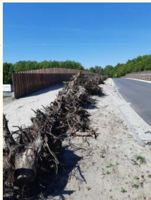
De nieuwe wildpassage, aangelegd direct langs de weg van brug over de A1 bij de Oxersteeg. Foto: Erik Lam
