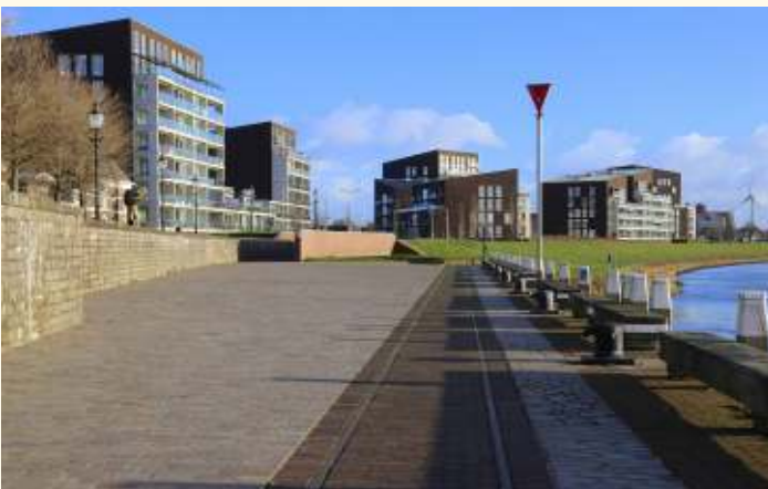
Pothoofd: nieuwe aanlegsteiger met rails. Op de achtergrond de bakstenen muur. Foto: Petro Hetjes
