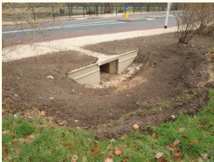
Een van de nieuwe tunnels onder de Ceintuurbaan door
