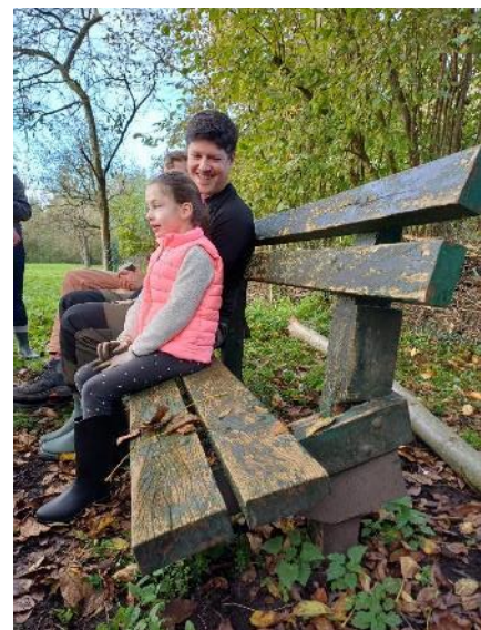
Afbeelding: de ingezakte parkbank is aan vervanging toe!
