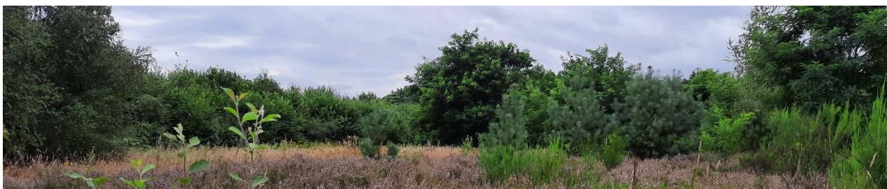
Tegelen: Ecoduct Wambach over de A74
