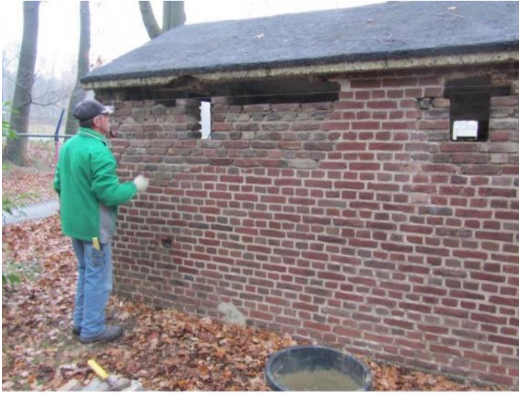
3. Vernieuwen onregelmatig metselwerk
