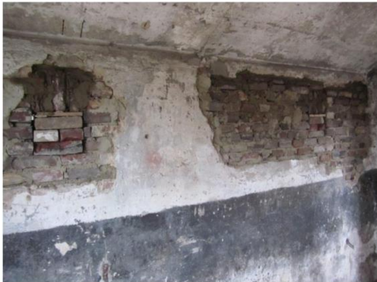
4. Onregelmatig metselwerk zichtbaar aan binnenkant
