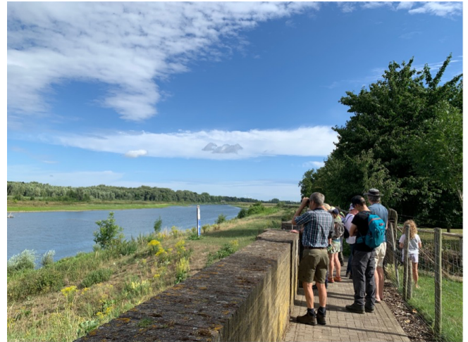
De dijk met muur tegen hoogwater.
