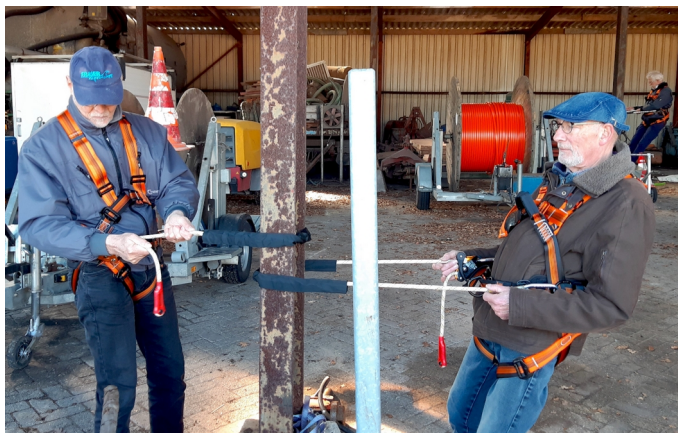
Beginfase techniek beheersing
