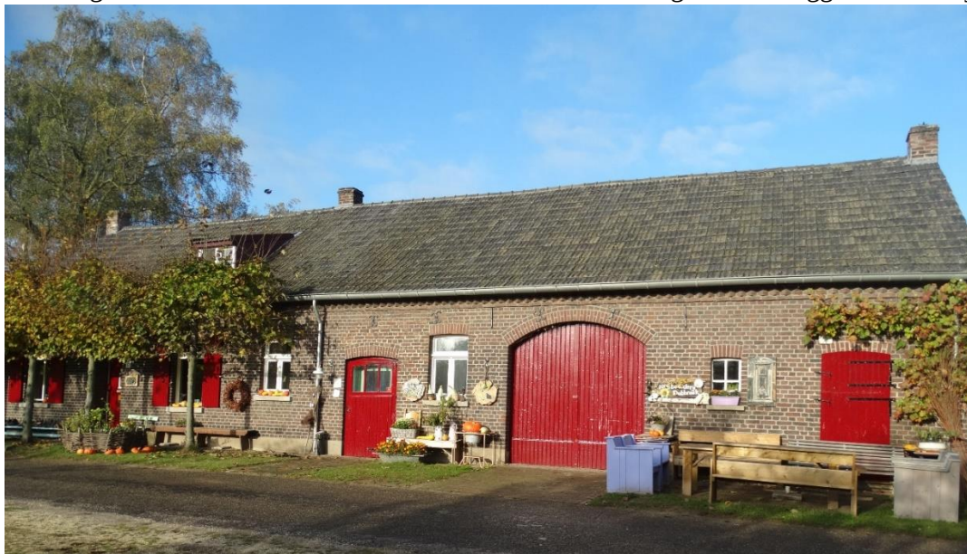
Foto: Langgevelboerderij in het Dubbroek
