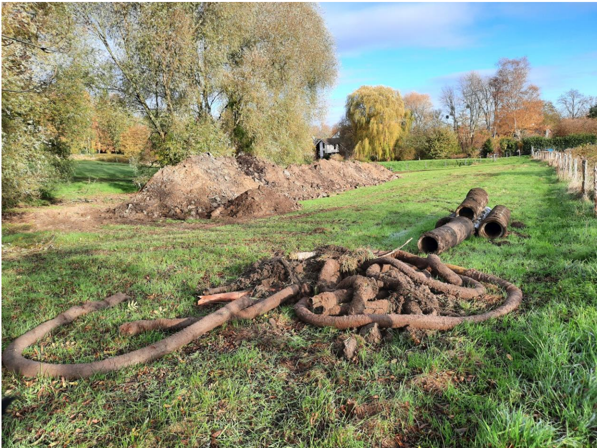
Verwijderen van drainagebuizen
