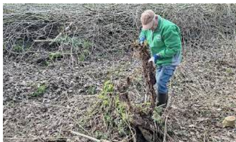
Gerrit is alvast begonnen met het herstel van de oude sloot.
