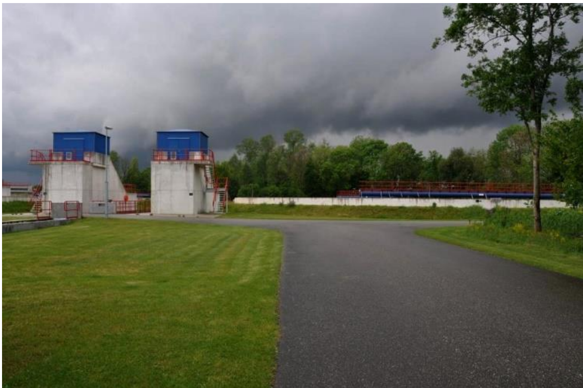
Figuur 2. Enkele gebouwen op het RWZI-terrein
