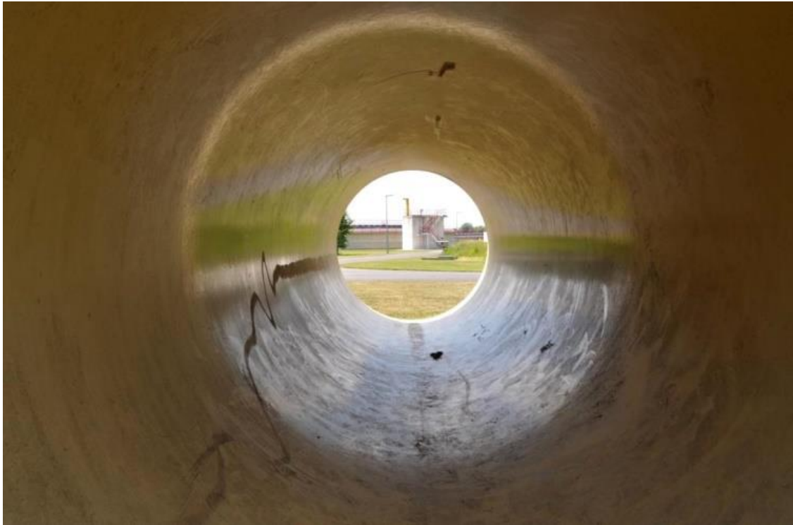
Figuur 1. RWZI-terrein gezien door rioolbuis
