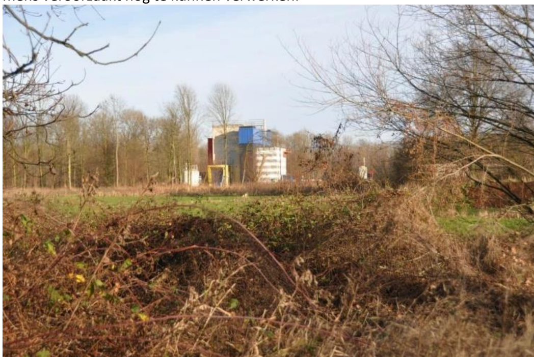
Figuur 12. Een kijkje van uit het rijke struweel op de gebouwen van het RWZI-terrein
