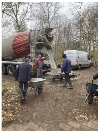
Het maken van de fundering startte al begin februari.
