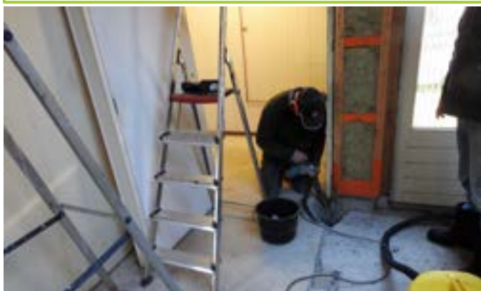
De renovatie is nog in volle gang. Hier is Adrie bezig met de verbouwing van het nieuwe deel van de keuken. (3 maart 2022)
