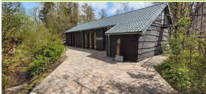
Terras bij De Bimd in renovatie. Situatie op 25-4-2021
