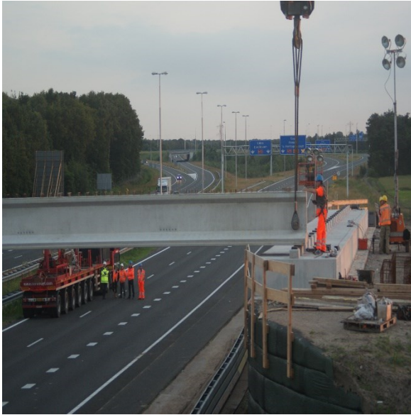
Bouw ecoduct A50
