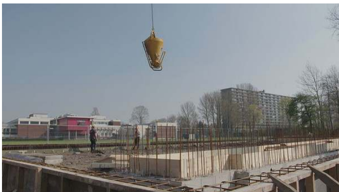
Bouwwerkzaamheden voor biomassacentrale in Zaandam
