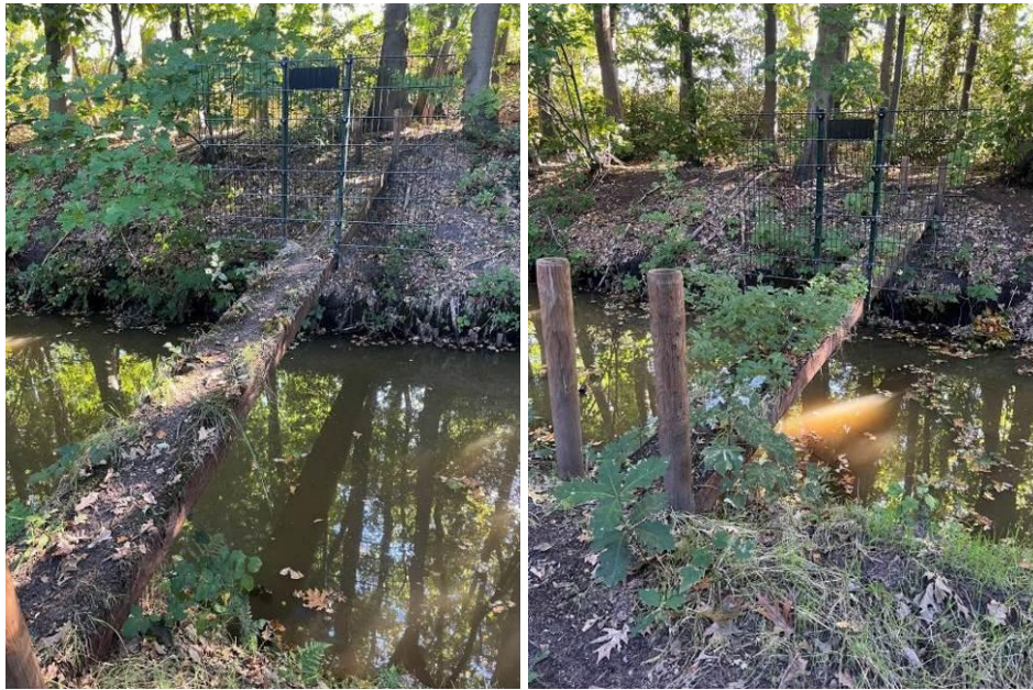
Foto's Bert: De linkse foto de belopen zuidelijke brug, foto rechts de niet belopen noordelijke brug.
