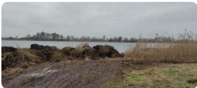
Uitgraven rietput door aannemer de Wit
