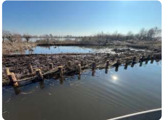
De 2 dubbele palenrijen opgevuld met takkenbossen
