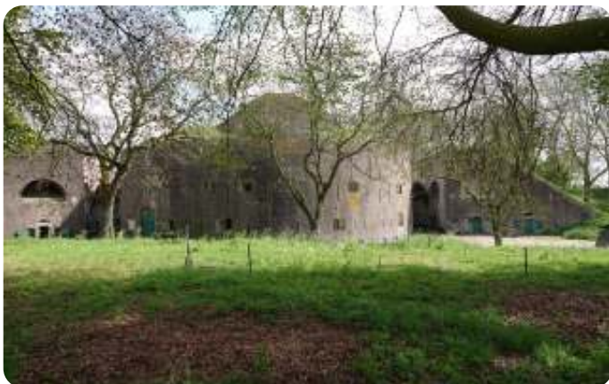
Torenfort Everdingen, gebouwd 1842-1847, onderdeel Nieuw Hollandse Waterlinie
