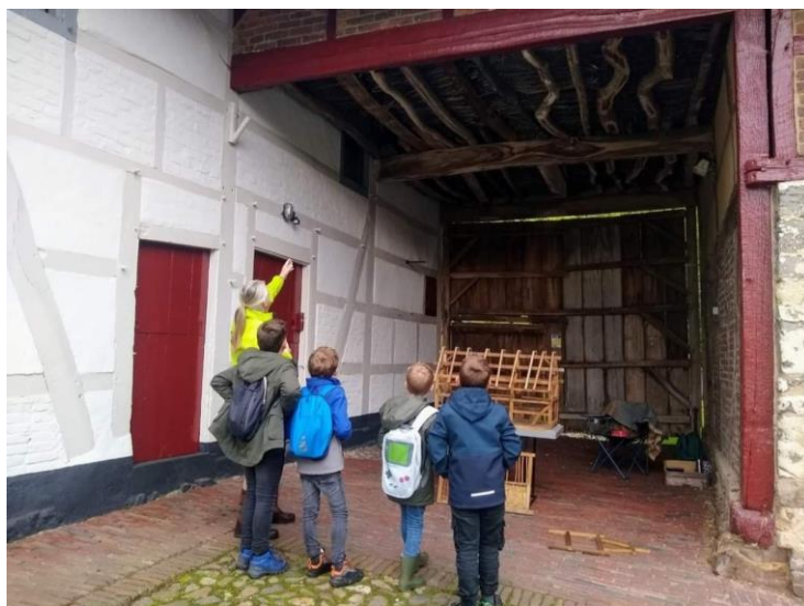
We zien er de balken maar ook de leem die gebruikt wordt om alles goed te laten aansluiten of zelfs waterdicht te maken.
