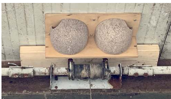
De nestkasten zijn los van de centrale aandrijfjas gemonteerd
